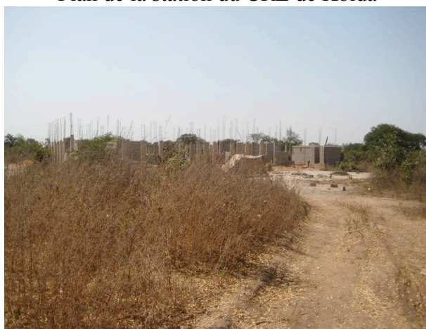
Institut islamique en construction sur le site du CRZ Kolda
